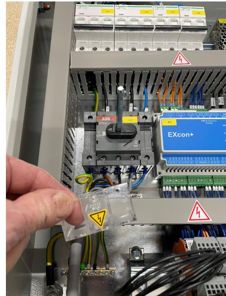
2) Schließen Sie abschließend die Versorgungsspannung am Hauptschalter an.
